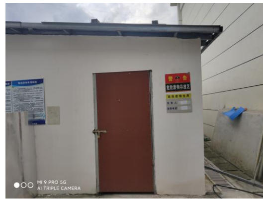
危废暂存间（外）
